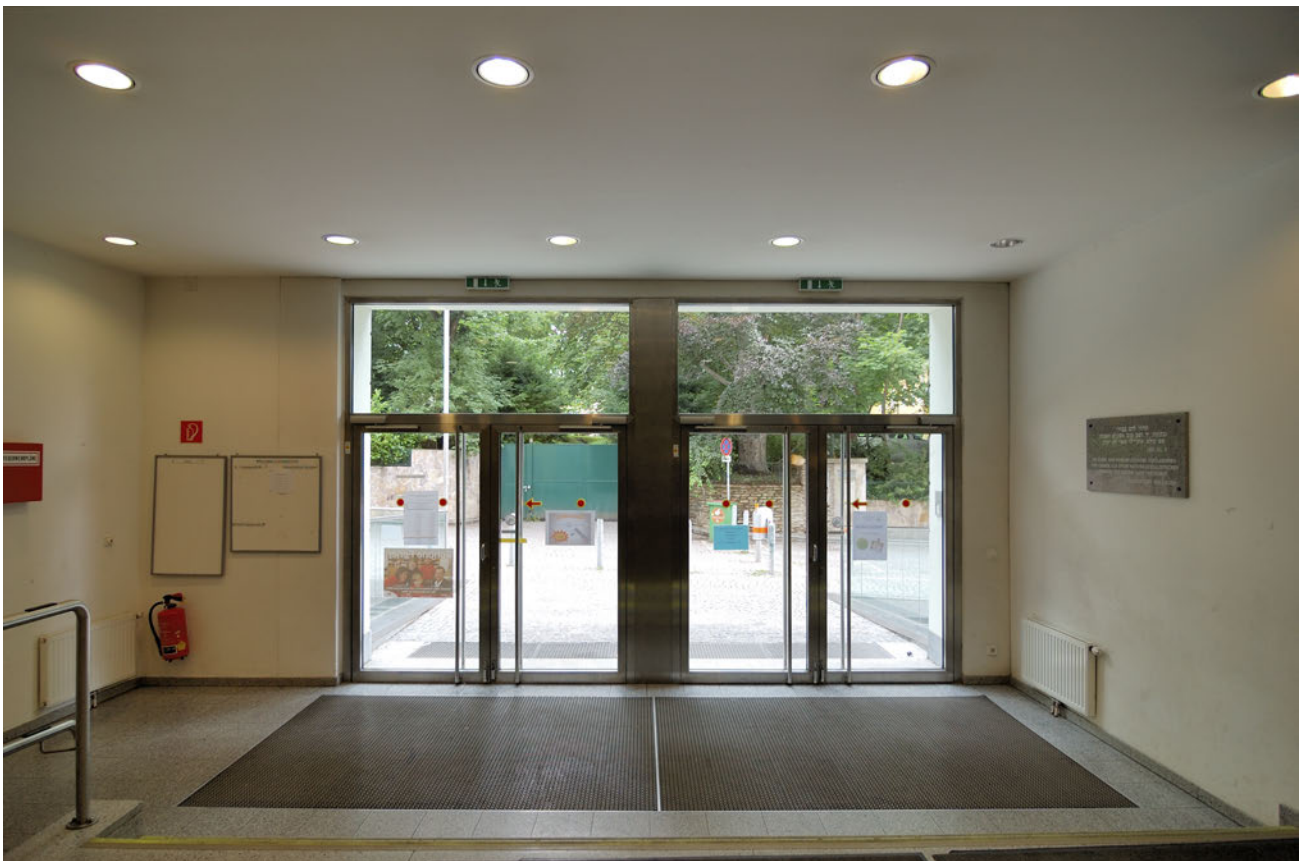
Abb. 10 Der neue, verbreitete, verglaste und behinderten gerechte Eingangsbereich, 2010
